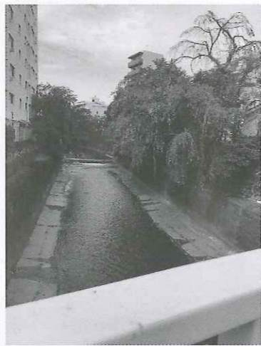
神田川の落合橋から川上を見ると、右手川岸に妙正寺川合流点②の痕跡あり
